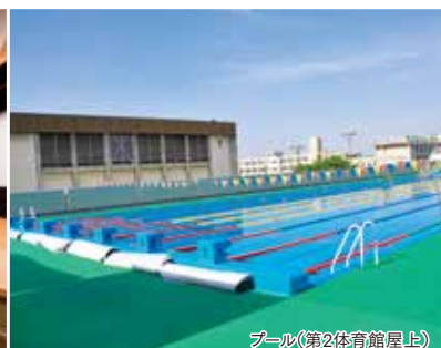
プール(第2体育館屋上)
